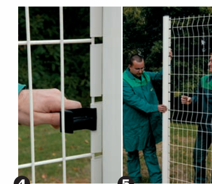
4 A rendszerhez ajánlott műanyag merevítő elhelyezése, amelyek a kerítésmezőnek az oszlop hornyában való rögzítésére szolgálnak a szerelés és a beton megkötése idejére (ezután kivethetők).
