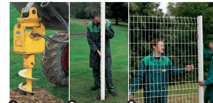
1 Lyukak készítése föld-fúróval egymástól 2,37 vagy 2,53 m távolságban a táblaszélességtől függően. (A furatok mélysége a talaj minőségének függvényében.)
