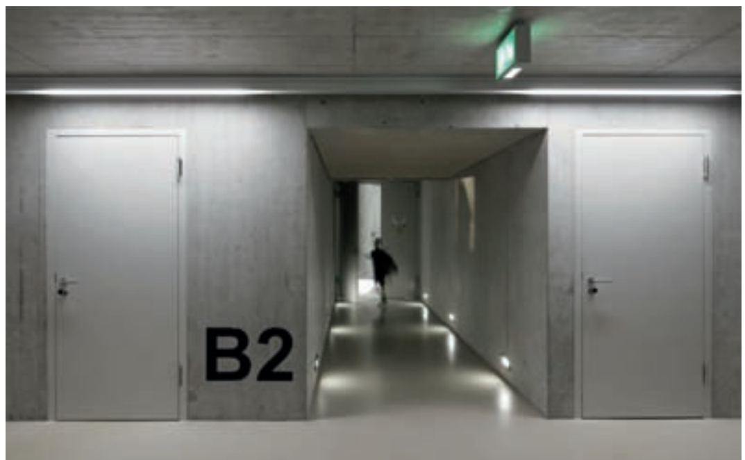
1 & 3 Massivholz-Rahmentüren mit feststehenden Seitenteilen und Edelstahlbeschlägen als EI30//VKF Brandschutzelemente mit Schallschutz 37 dB Rw,P. 2 Die Verglasung an den Stirnseiten und hinter dem tragenden Faltwerk bringt viel Tageslicht in die Hallen.
