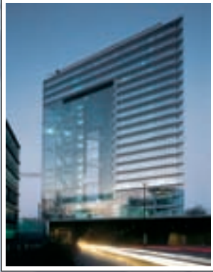
Das Stadttor: Von Petzinka Pink Architekten entworfenes Bürogebäude mit Doppelfassade – außen Glas-Stahl-, innen Buchenholz-Glas-Konstruktion, Stadttor 1, 40219 Düsseldorf.
