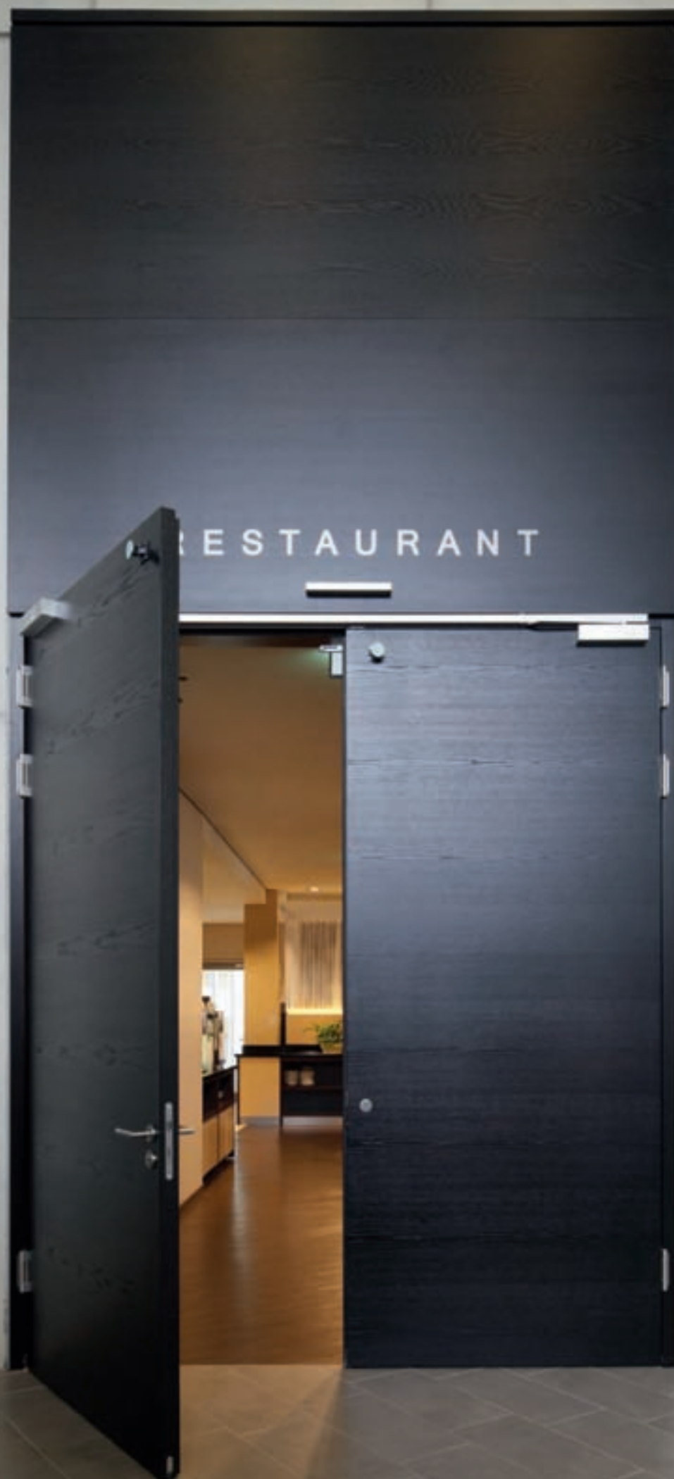
Oben und rechte Seite: Die zweiflügeligen T30/RS Saaltüranlagen 37 dB Rw,P mit Oberblende sind querfurniert und offenporig schwarz lackiert.
