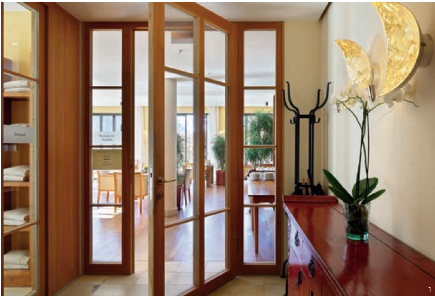
1 & 2 Optimale Belichtung tiefer Räume durch Glasrahmenelemente mit glastrennenden Sprossen in Lärchenfurnier, Schallschutz 37 dB Rw,P.
